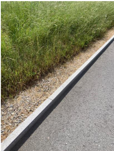
Abb. 4: Fahrbahn- und Gehwegabschlüsse ohne Einfahrten, bei wenig befahrenen Vorplätzen, bei Gehwegen oder Böschungen (einfacher Randabschluss)
