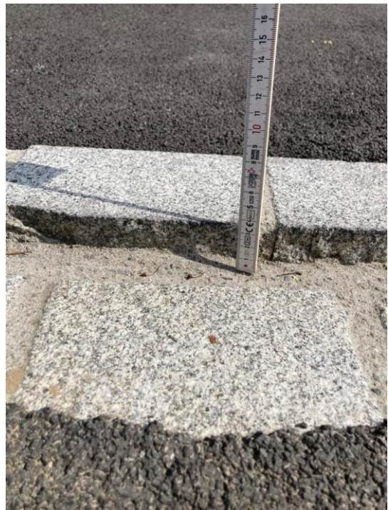
Abb. 1: Fahrbahn- und Gehwegabschlüsse bei Einfahrten, Vorplätzen oder Gehwegen (doppelter Randabschluss)
