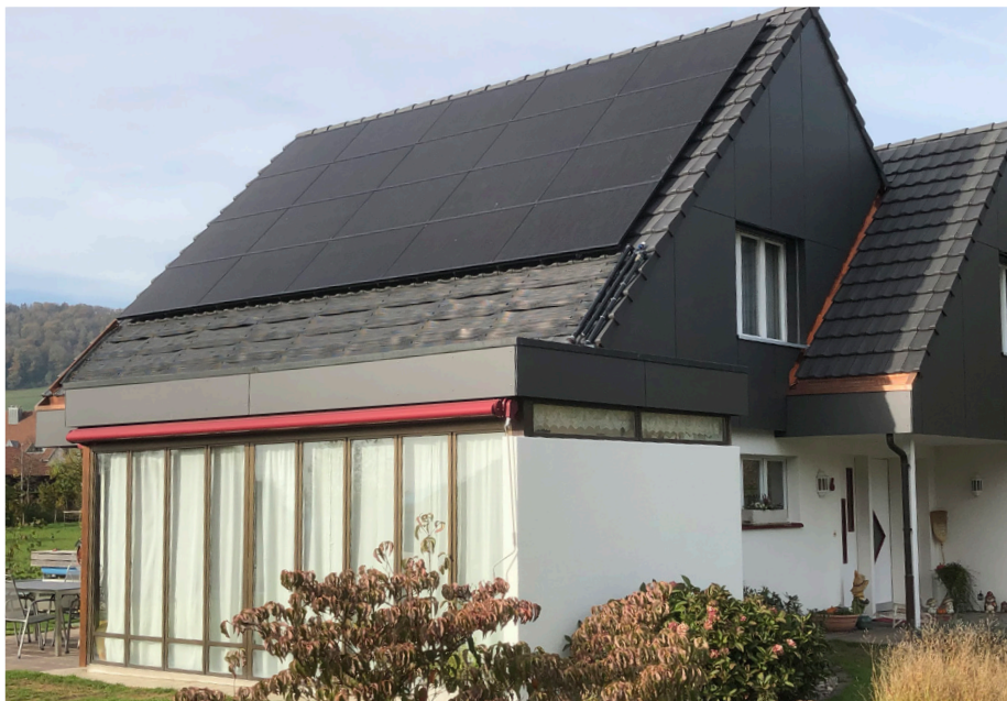
Solarpanels auf dem Dach der Familie Frauchiger
