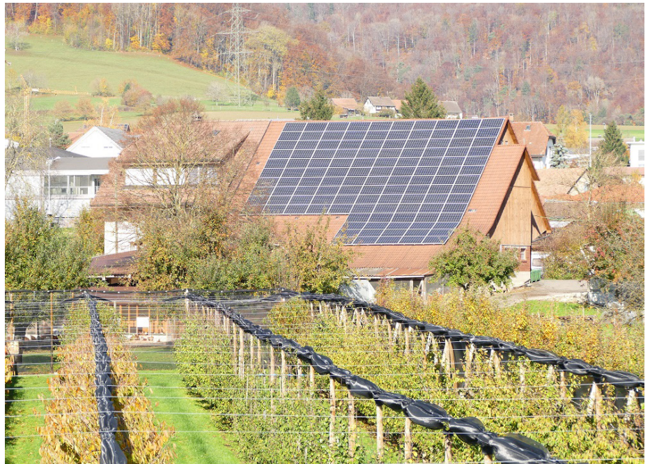
Kraftwerk auf dem Dach: Erni Obstbau produziert 60% des benötigten Stroms selbst.
