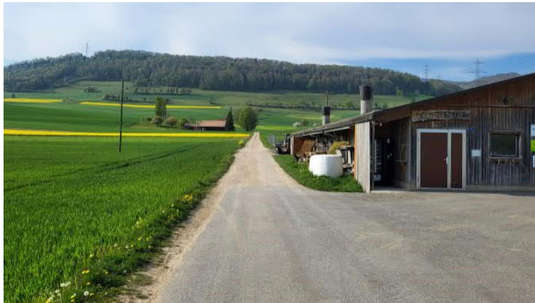
Abbildung 2: Flurweg nördlich Hauptstrasse (Blickrichtung Nordwest)
