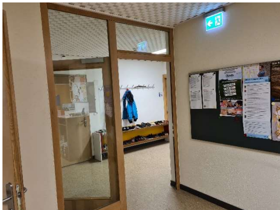
Abb. 19, Vorraum Office best. Trennwand
