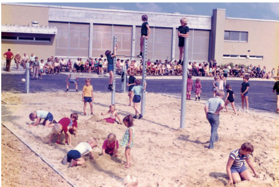
Einweihung der Mehrzweckhalle 1973
