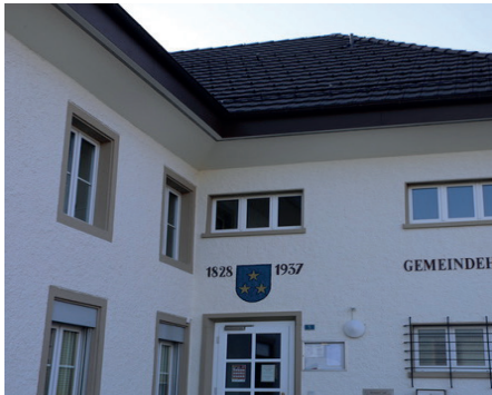
Gemeindeforum (früher Schulhaus)
