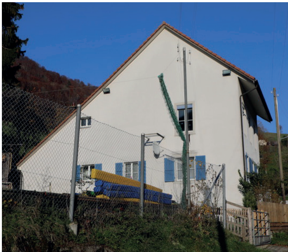
Das Schulhaus in Rohr, heute Gemeindehaus
