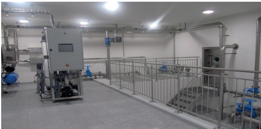
Innenansicht des neuen Reservoirs
